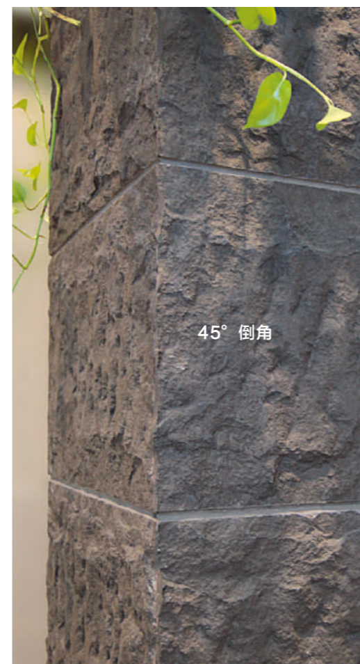
阳角处理图示：用整砖切，45° 对碰，同色填缝剂补缺。
