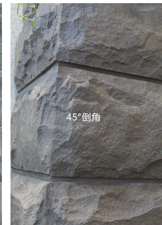
阳角处理图示：用整砖切，45°对碰，同色填缝剂补缺。
